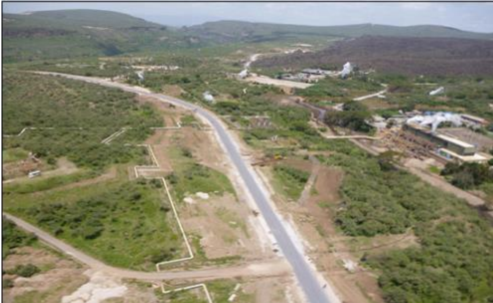
Fig. 8 : Vue du gisement d'Olkaria (Kenya) avec une des unités de production électrique (140 MW) connectée à un réseau transportant la vapeur depuis les puits de production (Photo J.Varet, 2013)
